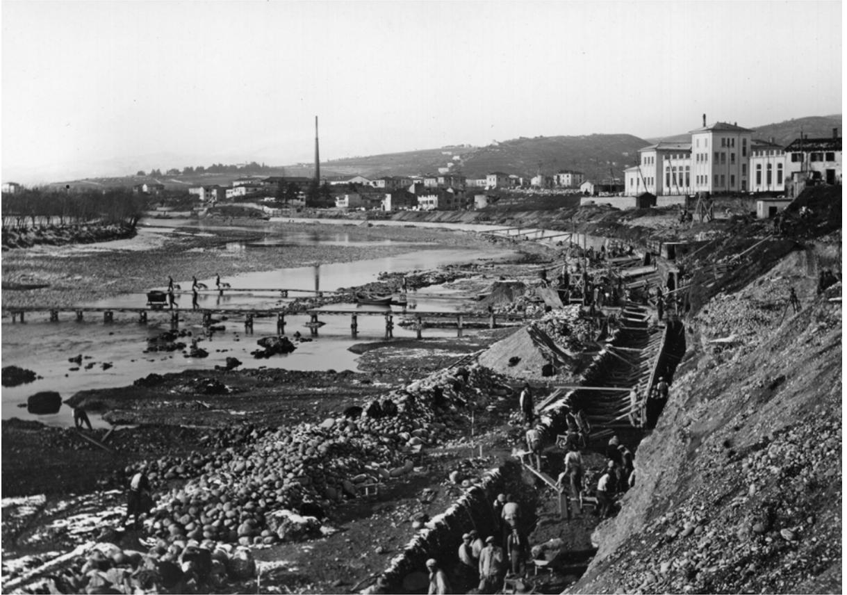
Panoramica del cantiere dove sono visibili la trincea di fondazione e la passerella in legno per i carrelli Decauville che attraversava il fiume.
