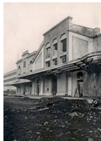
Il magazzino tabacchi greggi dopo i bombardamenti della Seconda Guerra Mondiale. Sullo sfondo l'edificio produttivo della Manifattura Tabacchi (Archivio di Stato di Verona).
