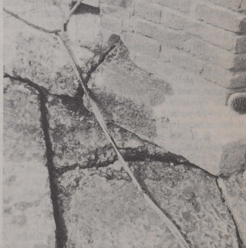
Delle vere e proprie colate di cementi speciali sono state necessarie per sistemare le lastre. Le foto mostrano due particolari del lavoro alla balconata dove si giungerà con l'ascensore. Di lassù si gode una visione spettacolare della città. Entro Natale, intanto, dovrebbero concludersi i restauri esterni.
