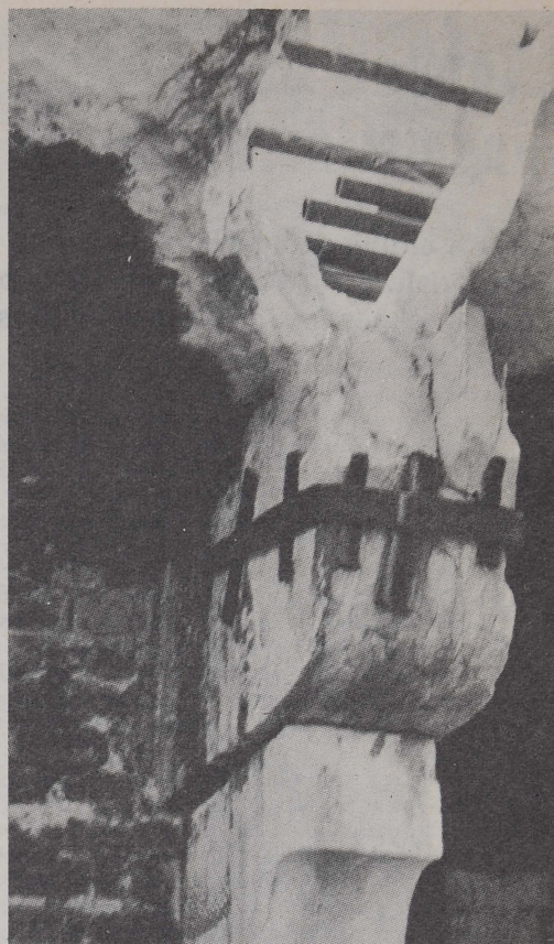
Un minuzioso lavoro è necessario per stuccare e ancorare le pietre, spesso sfaldate come i mattoni. La foto qui sotto è un eloquente esempio delle condizioni della torre. La saldatura delle crepe prosegue centimetro per centimetro.
