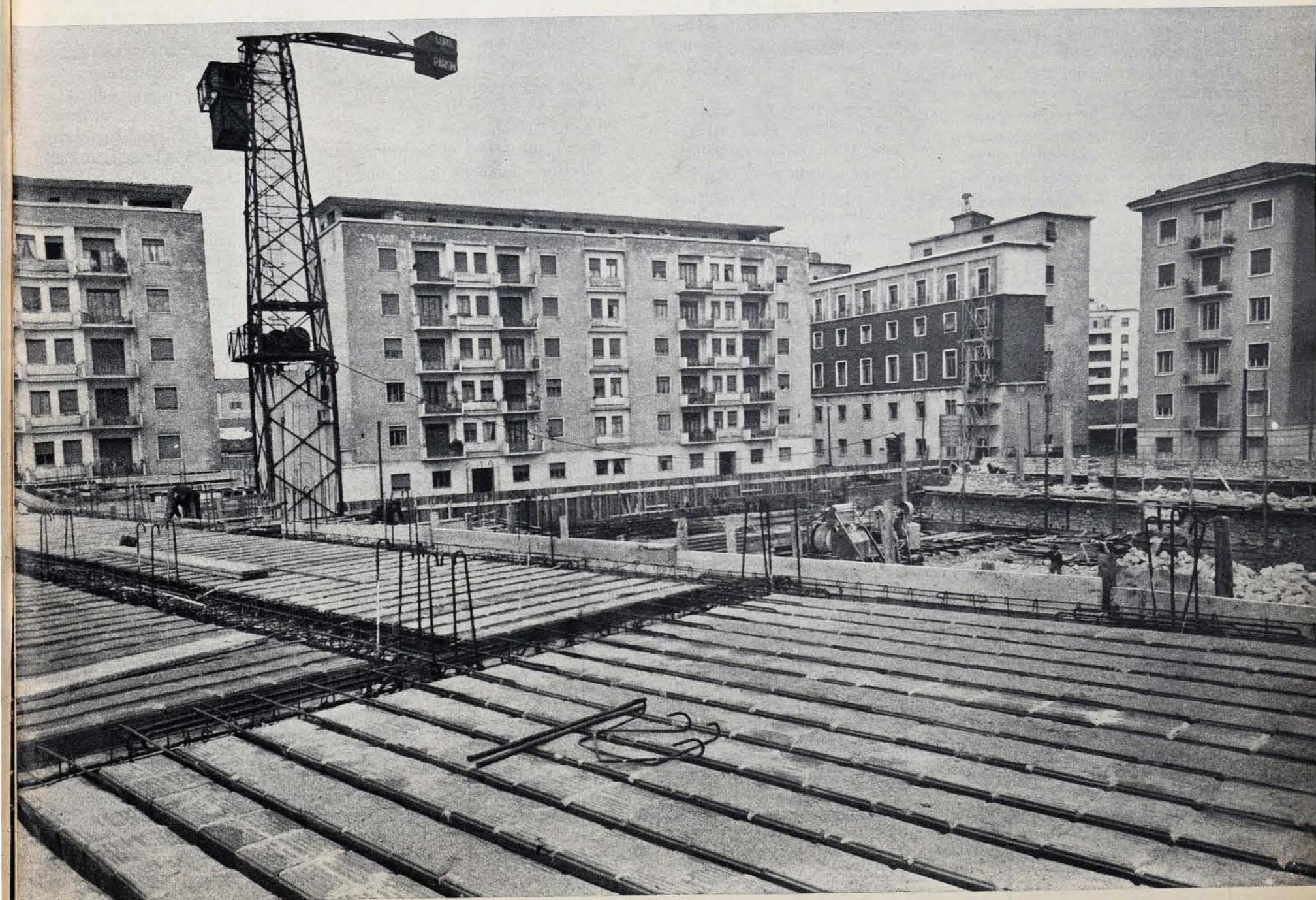
La costruzione in corso (gettata del solaio del piano terra) della scuola media statale di via Locatelli (zona ex Riformati). Il grande edificio si comporrà di 25 aule, aula magna, uffici e servizi, nonché di palestra in costruzione separata con docce ecc.
