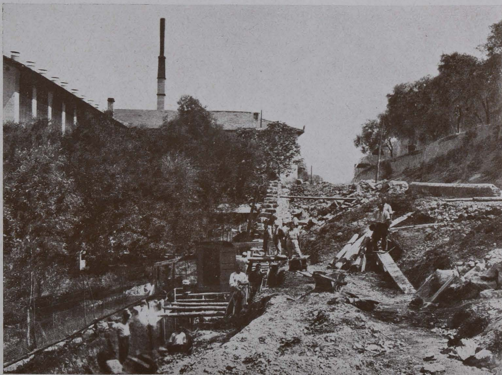
Il congiungimento presso la Fabbrica di magnesia di Magagnano tra il tronco in costruzione e quello già eseguito.
