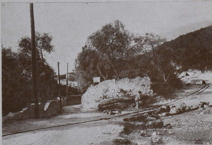
La vecchia e la nuova strada presso Magagnano.
