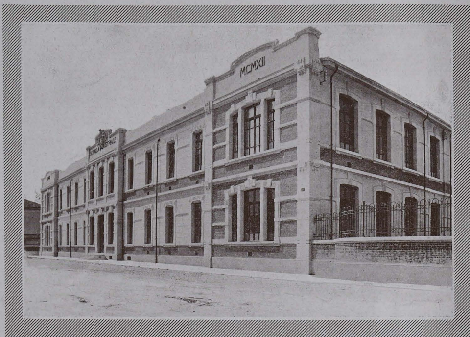
R. Scuola Industriale di Verona - La facciata
