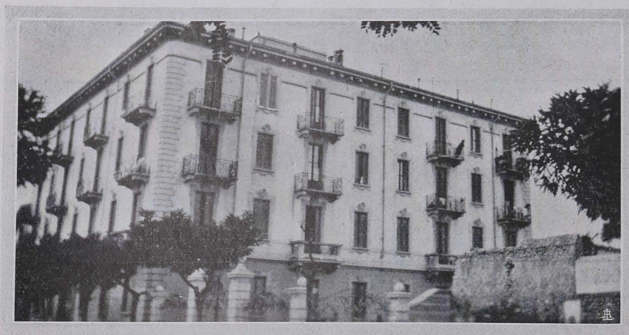
Fabbricato d'abitazione civile in Via Collegio Angeli - Verona
