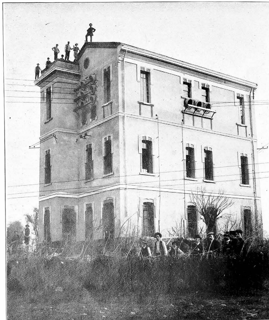
Cabina di sezionamento di Bassano.
