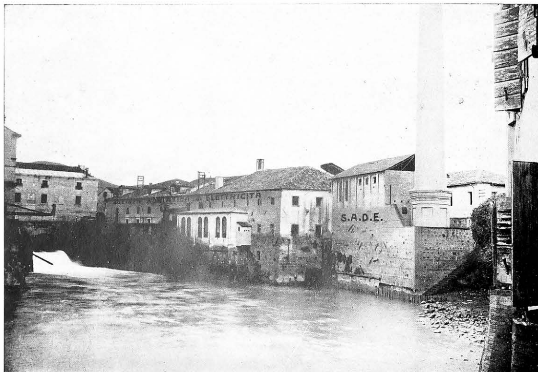
Battaglia - Officina Idroelettrica, riserva termica e canale.
