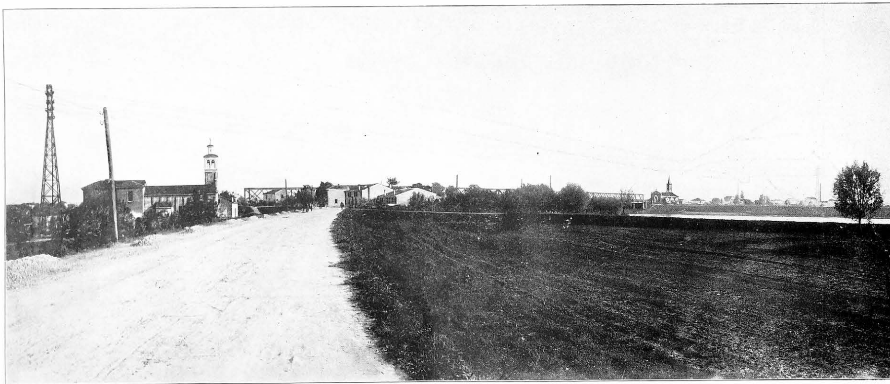
Pontelagoscuro - Attraversamento del fiume Po. Larghezza m. 500.
