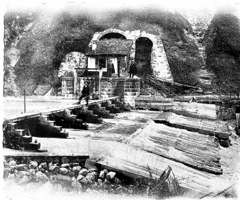
Parte della diga degli impianti idroelettrici di Villabruna.
