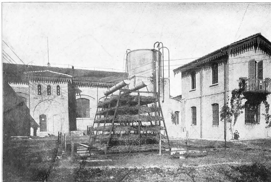
Ravenna - Cortile interno officina. Impianto refrigerante a cascata, per l'acqua di circolazione Abitazione impiegati.
