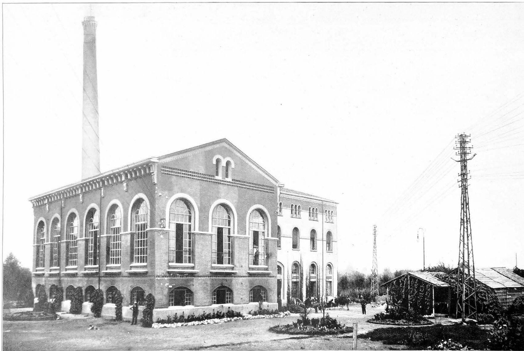
Padova - Centrale generatrice termica di riserva e stazione di trasformazione.
