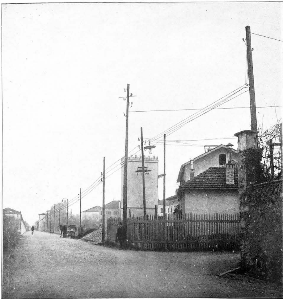
Tipo di cabina di trasformazione nella zona di distribuzione del Caorame.
