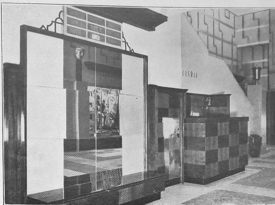
Particolare della cassa per la galleria. Porticina della cabina di proiezione e apparecchio di segnalazione luminosa della parte del programma in proiezione. Il mobile è in noce verniciata a spirito con elementi a venatura alternata orizzontale e verticale, zoccolino e cornicietta in nero. Lo specchio è in parte lucido e in parte smerigliato.
