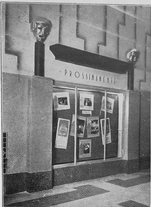
Ingresso. - Particolare di una nicchia per la pubblicità. - La illuminazione delle fotografie è data da lampadine interne poste in alto.
