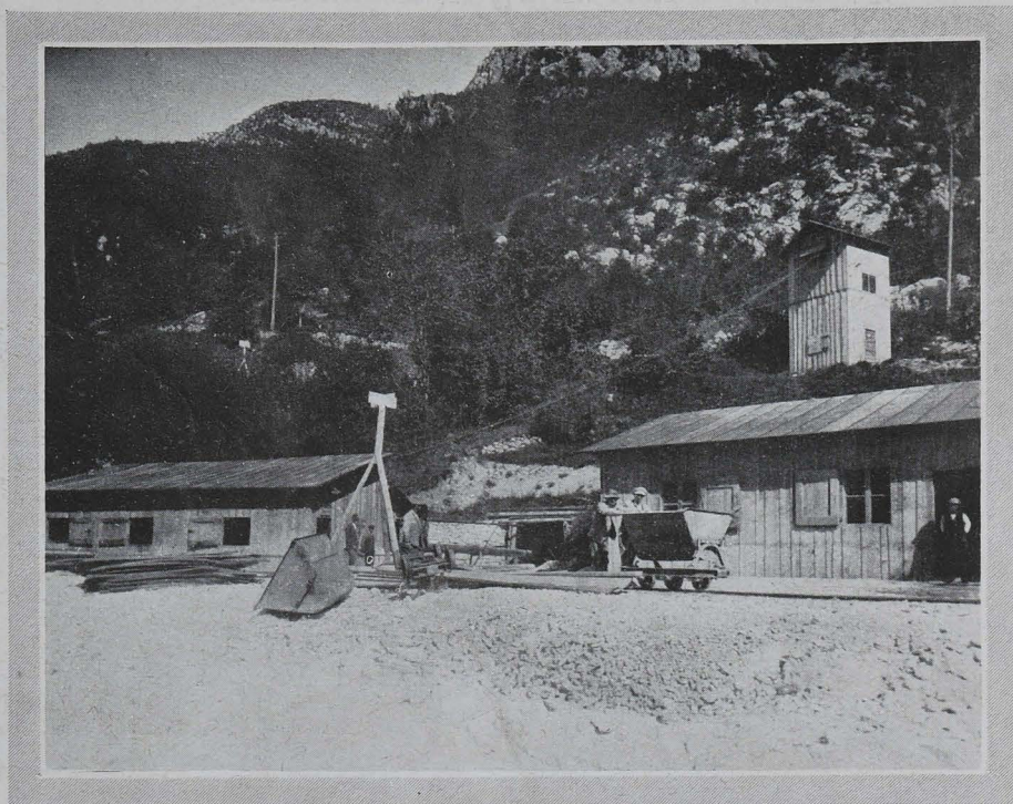
Cantiere di Barcesino.
