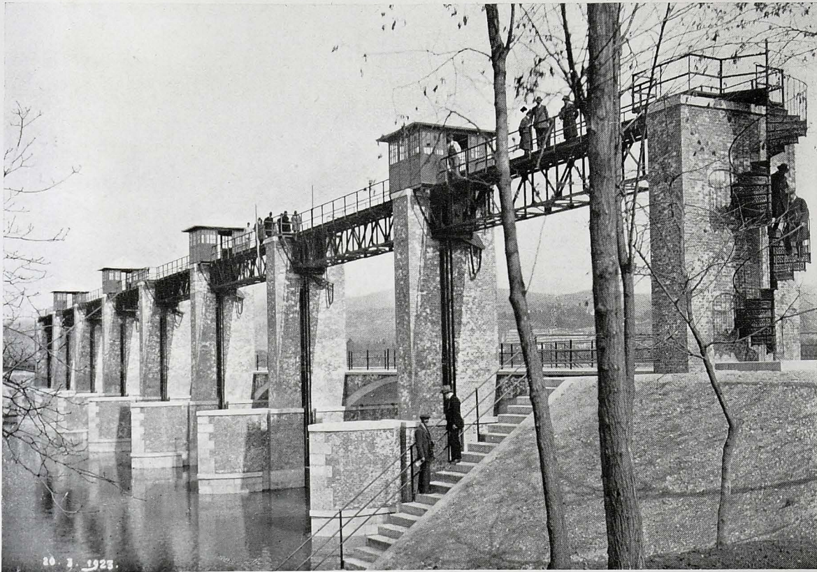
Fig. 16 - VEDUTA D'INSIEME DELLO SBARRAMENTO
