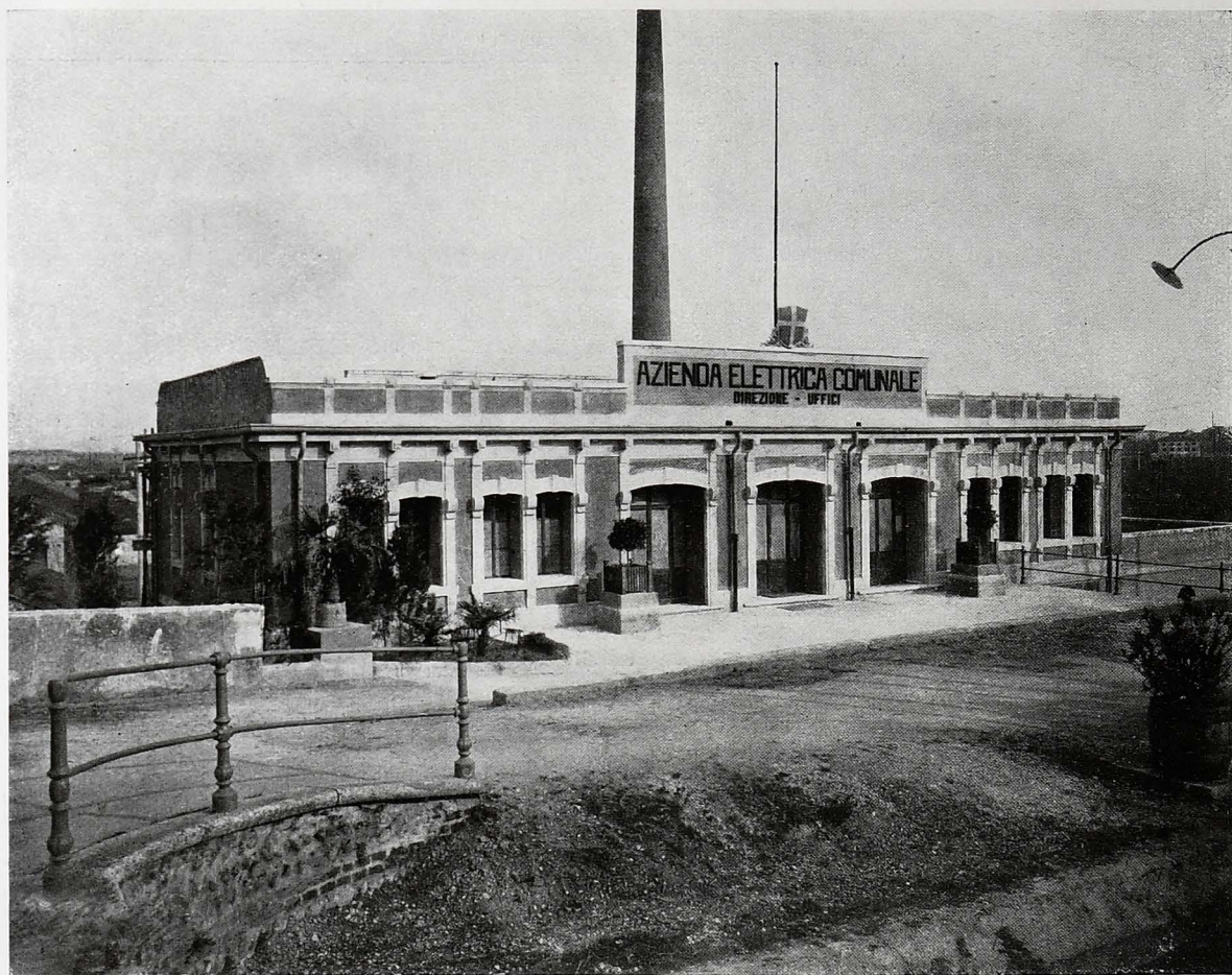
Fig. 25 - DIREZIONE E UFFICI DELL'AZIENDA ELETTRICA COMUNALE
