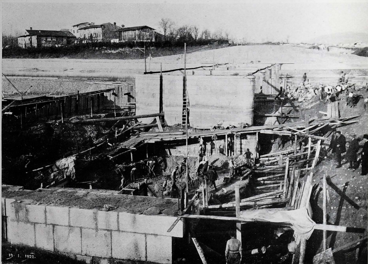
Fig. 10 - FONDAZIONE DELLA VI PILA E GALLERIA DI DRENAGGIO VERSO I POZZI
