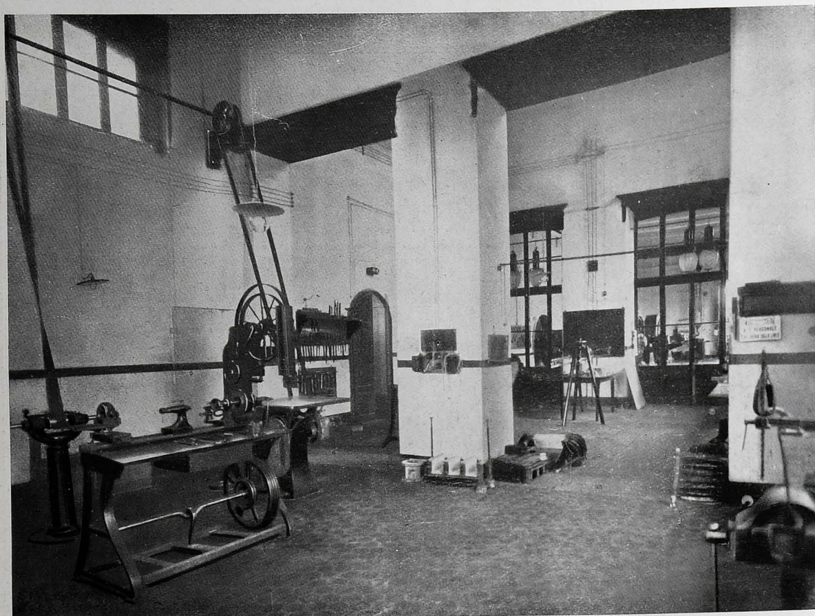
Fig. 3 - OFFICINA IDROELETTRICA DI BASSO ACQUAR - SALA DELLE RIPARAZIONI
