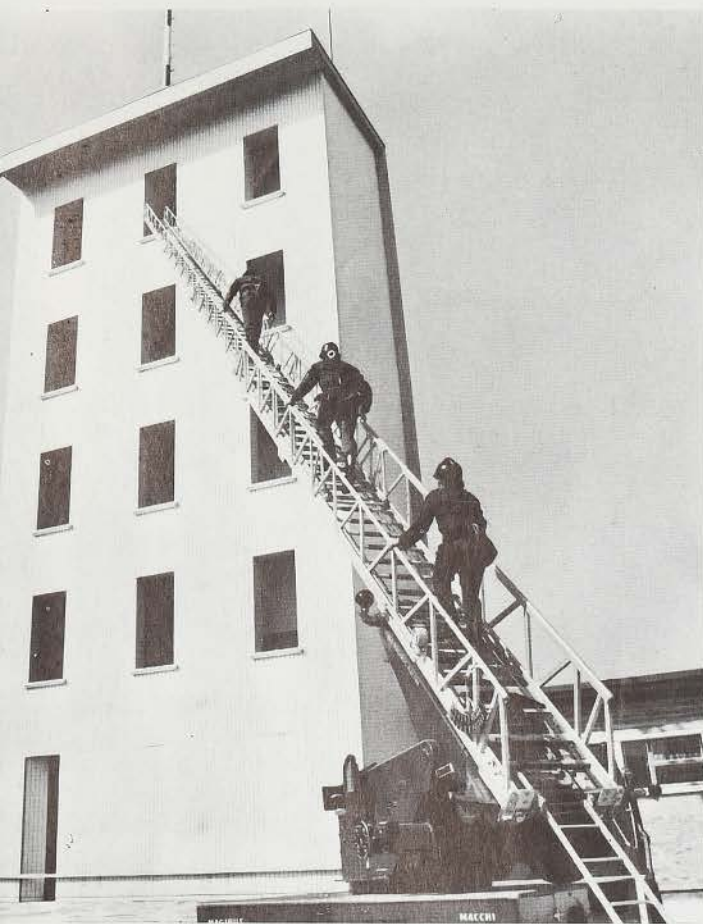
La nuova Caserma dei Vigili del Fuoco, in area già di proprietà provinciale in Via Polveriera Vecchia, nel quartiere di Borgo Roma, si presenta come una delle più ampie e funzionali caserme di cui oggi il Corpo disponga in Italia. Nella foto: la torre delle esercitazioni.
