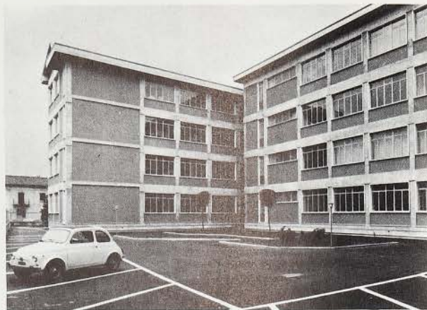
Una veduta della nuova sede dell'Istituto Tecnico per ragioniere e geometri di Legnago, intitolato a Marco Minghetti: l'edificio si presenta non solo pienamente rispondente alle esigenze scolastiche sotto l'aspetto funzionale, ma anche come un valido elemento del tessuto cittadino.
