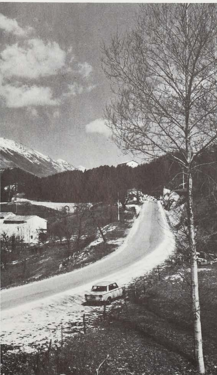
Una veduta della provinciale Caprino - Spiazzi - Ferrara di Monte Baldo. La strada, di quasi undici chilometri, ha un nastro bitumato di nove metri. La pendenza massima è dell'otto per cento e solo in qualche punto. Ne è risultata insomma un'arteria molto agevole, con curve di ampio raggio, panoramica, atta ad assorbire l'intenso traffico turistico al quale la zona è interessata. Per queste sue brillanti prestazioni essa è stata scelta dall'A.C.I. di Mantova per lo svolgimento della prima edizione di un'importante corsa automobilistica.
