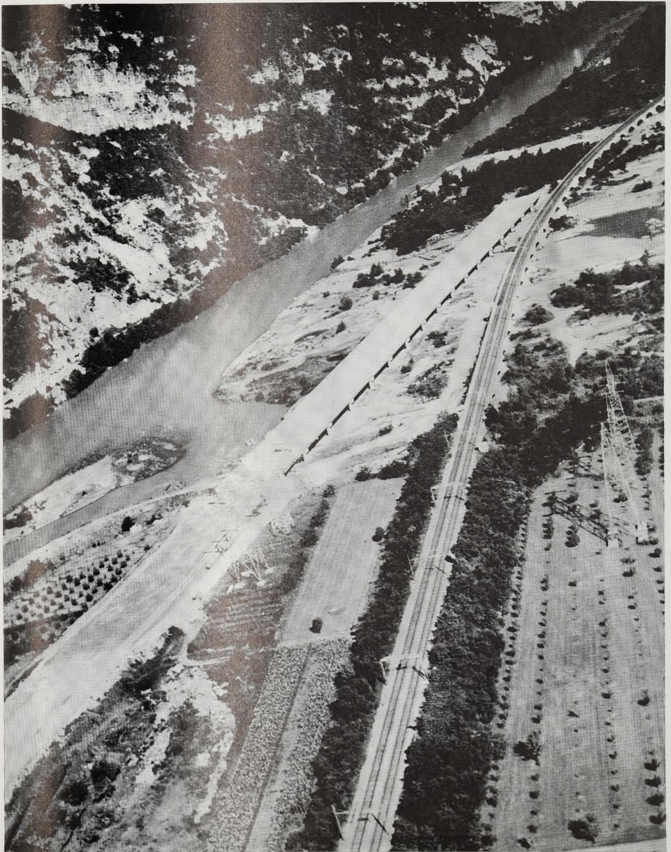
Veduta aerea del viadotto dell'autostrada del Brennero sul torrente Avisio
