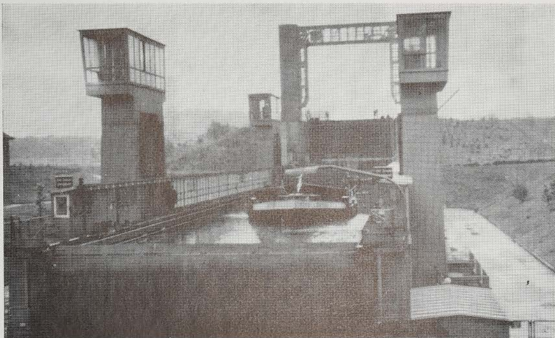
Elevatore di Henrichenburg nella Germania Occidentale
