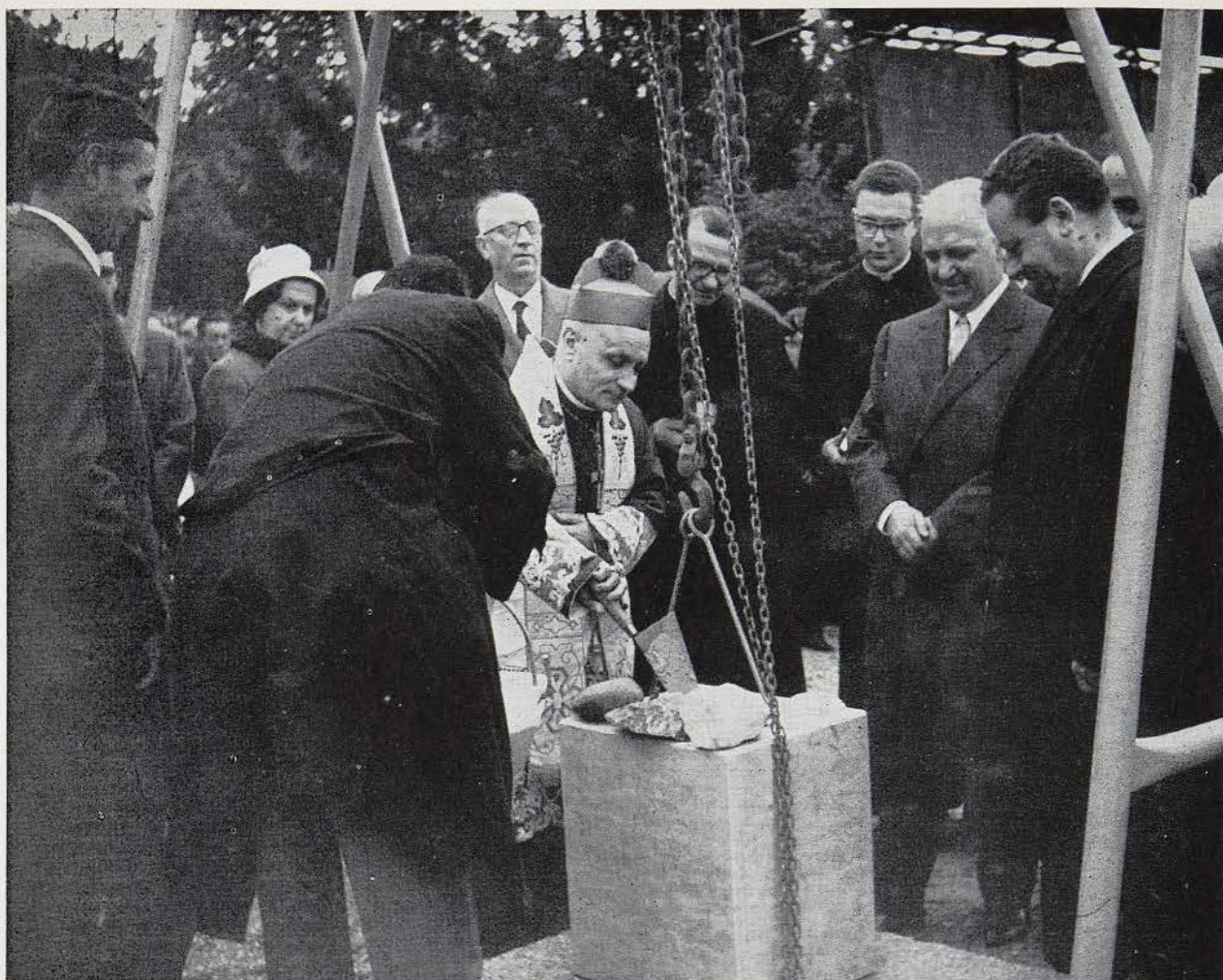
Un momento della cerimonia per la posa della prima pietra del costruendo complesso ospedaliero di Marzana. Tra i presenti era anche una folta rappresentanza dell'ospedale psichiatrico "gemello" di Lannemezan, che sorge sui Pirenei.
