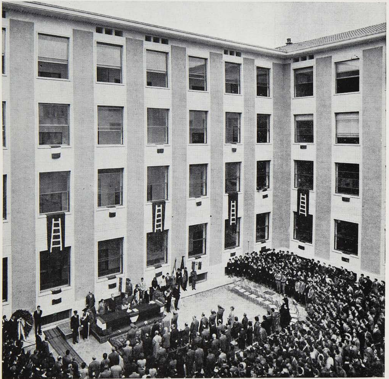
Il "Lorgna" di corso Porta Nuova è uno dei migliori istituti tecnici finora realizzati dall'Amministrazione provinciale.
