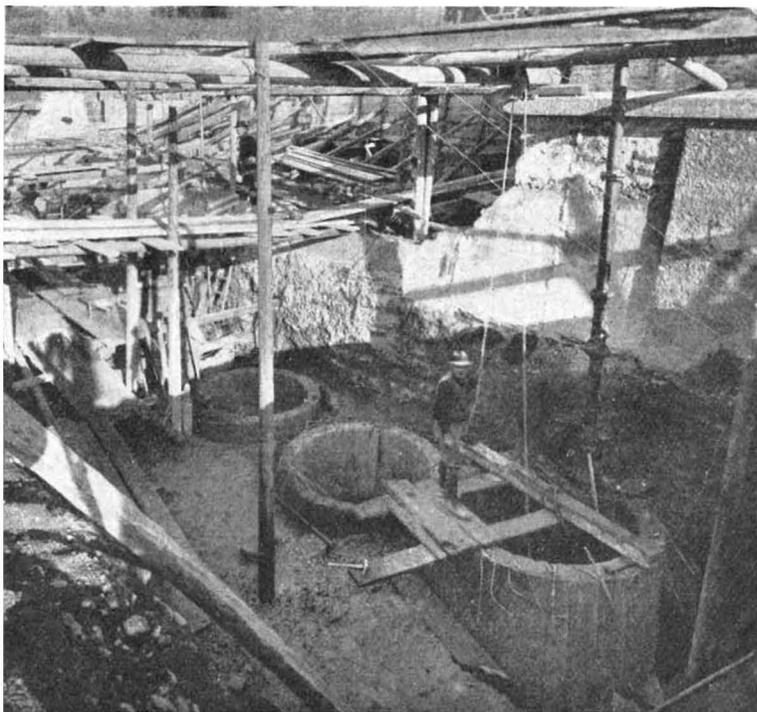
Fig. 202. - Ponte della Vittoria sull'Adige a Verona: fotografia presa durante l'affondamento dei pozzi.
