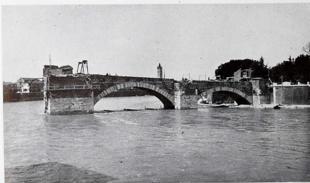
La ricostruzione del ponte scaligero in fase avanzata (maggio 1950). Sono state rifatte per intero le due arcate minori, col reimpiego parziale dei materiali originali, e seguendo la tecnica primitiva. Si è escluso totalmente l'uso del cemento armato.
