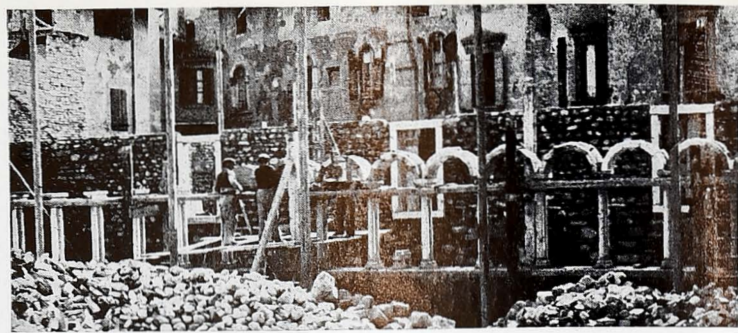
La parte distrutta del chiostro capitolare nella prima fase ricostruttiva. Si ricollocano le colonnine binate superstiti e i frammenti originali degli archetti, integrati da parti nuove in sostituzione delle mancanti.
