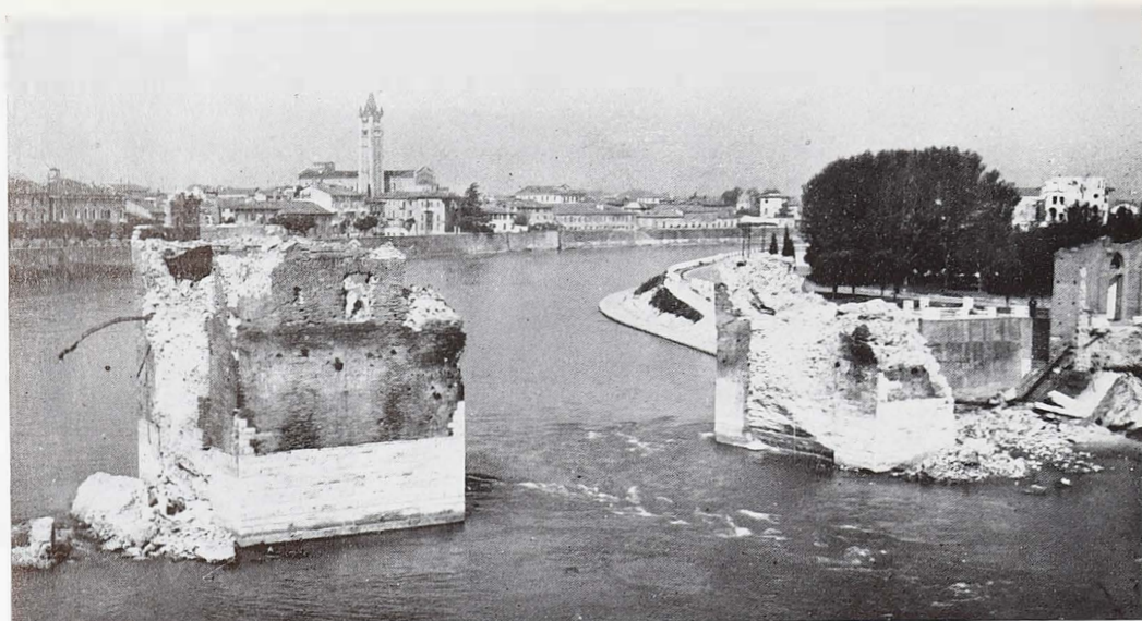
Il ponte scaligero dopo la distruzione. Crollate interamente le tre grandi arcate, sono rimaste le due pile-torri gravemente lesionate dall'esplosione.
