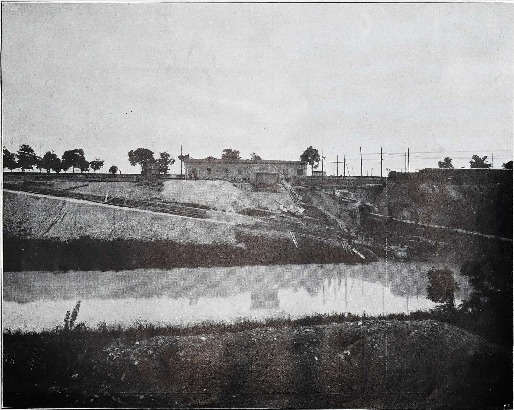
La nuova Centrale Elettrica in costruzione.
