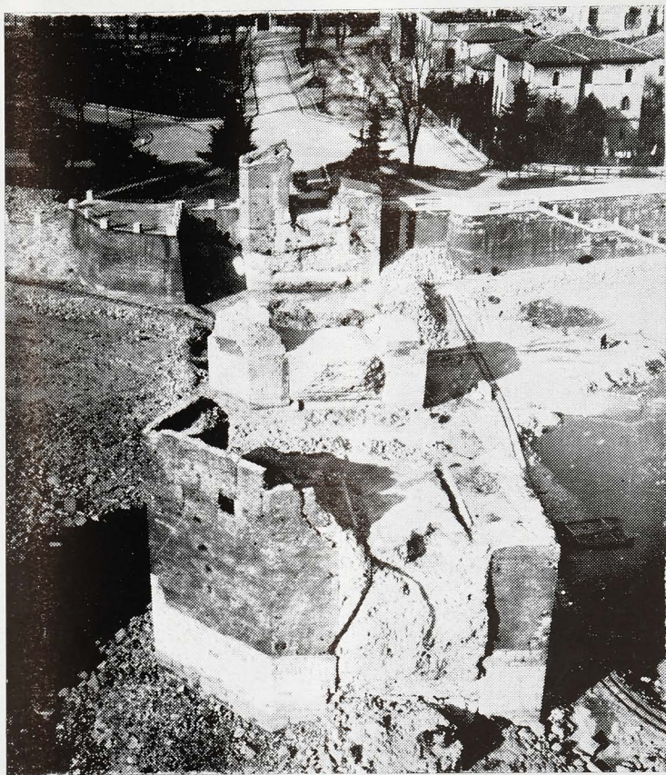
Il Ponte di Castelvecchio durante i lavori di sgombero delle macerie.
