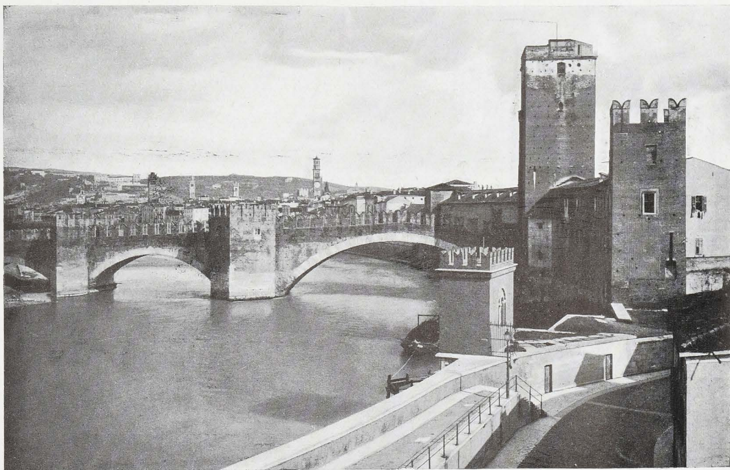
PONTE DI CASTELVECCHIO SULL'ADIGE.
