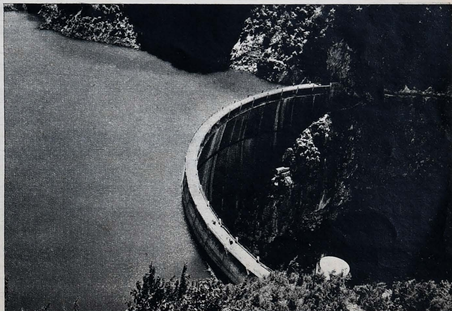
Impianto idroelettrico del Leno, dell'A.G. SS. MM. di Verona: la diga di Specheri.
