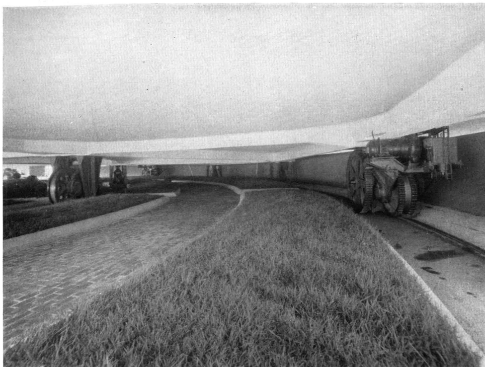
VEDUTA DELL'INNESTO DEI CARRELLI CON L'OSSATURA DI CEMENTO ARMATO.
