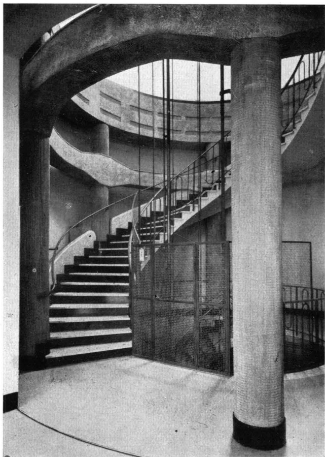
DETTAGLIO SCALA ELICOIDALE, DOVE È VISIBILE LA TRAVATURA WIERENDEL E L'ANELLO DI SPINTA.
